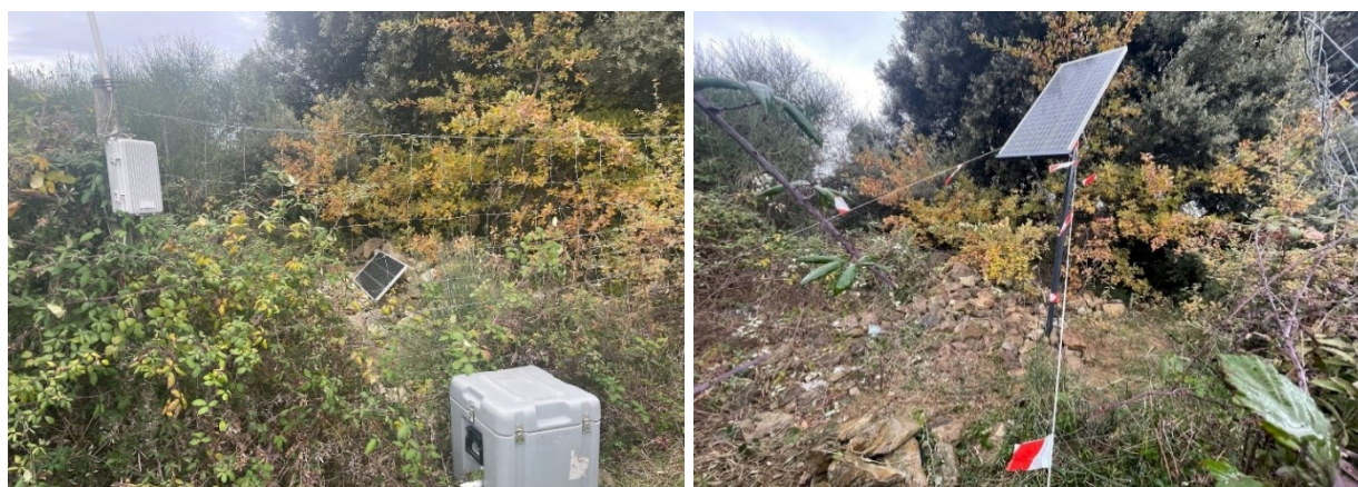
Figura 2.13. Manutenzione a MALA2: Pulizia della vegetazione e spostamento in alto del pannello solare su apposita struttura di ferro. Foto prima (sx) e dopo (dx) la manutenzione di Dicembre 2024.
