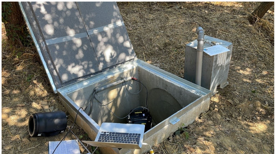
Figura 2.2. Stazione sismica AROB, installata in località Ripa di Olmo, Arezzo (AR).
