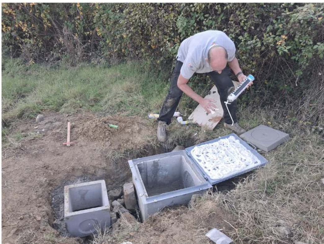
Figura 2.6: Preparazione e coibentazione dei pozzetti per il sensore sismico a larga banda e l'accelerometro.
