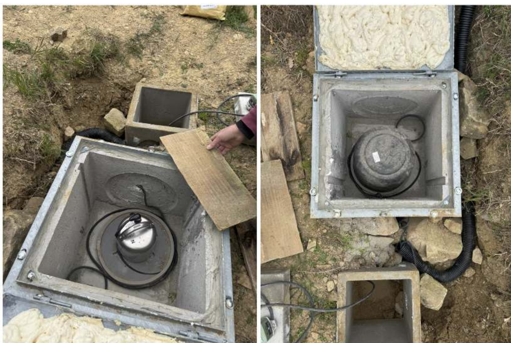
Figura 2.7: Installazione dei sensore sismico a larga banda e dell'accelerometro.
