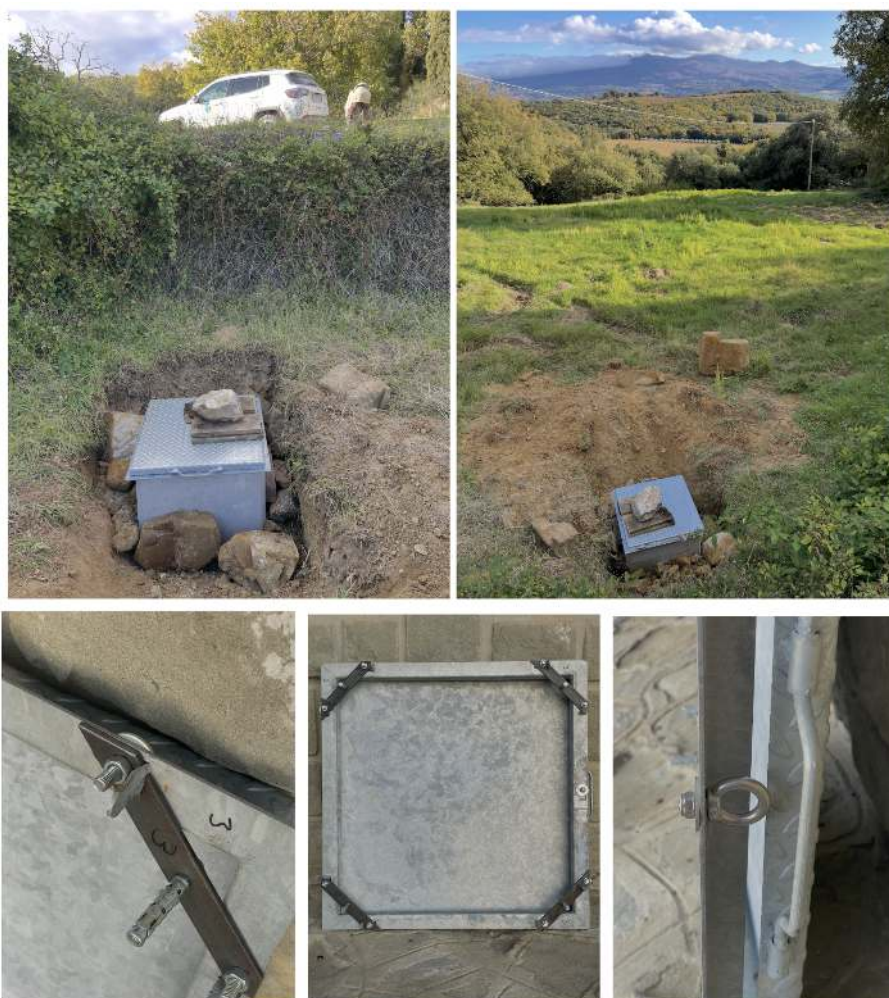
Figura 2.5: Pozzetto in cemento con copertura di ferro zincato.
